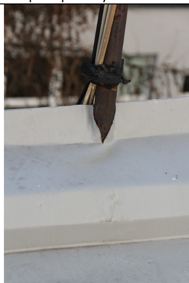
Chybně provedený prostup krytinou střešní nástavby
