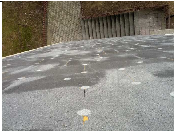
Vniklé spáry vlivem slunečního záření
