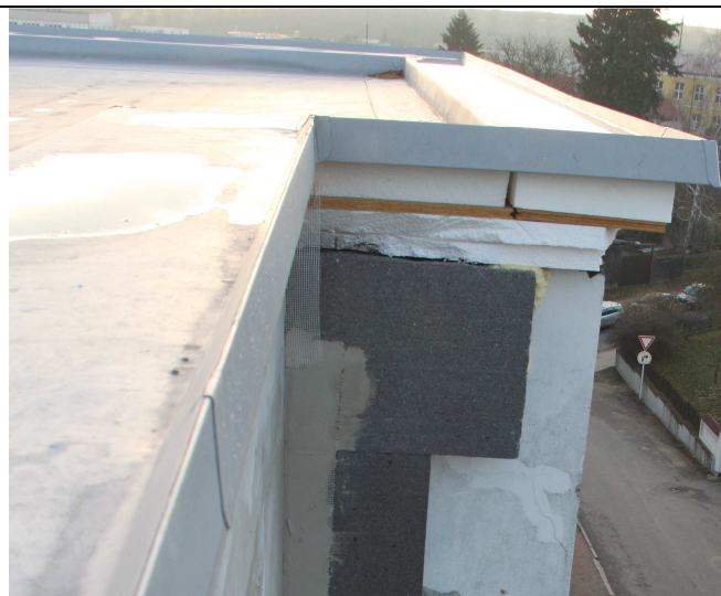
Nesprávně provedené nastavení atiky; spád na opačnou stranu; chybějící návaznost na zateplení svislých konstrukcí
