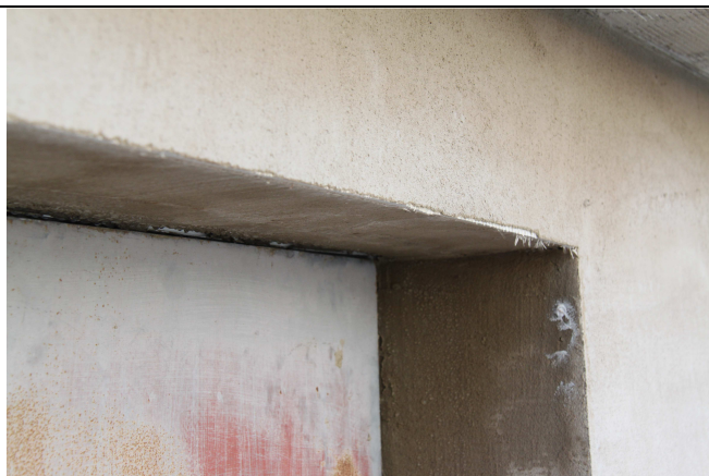
Nevhodně provedené nadpraží (dveře při otevření zadržávají o rohovou lištu)
