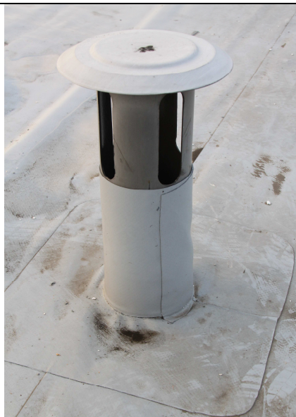
Nesprávně provedený detail opláštění prostupu krytinou střešní nástavby
