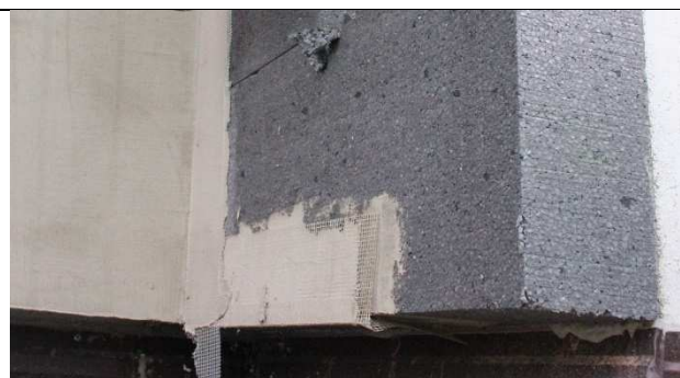
Chybějící základová lišta a nedořešený detail zateplení nad bočním vstupem
