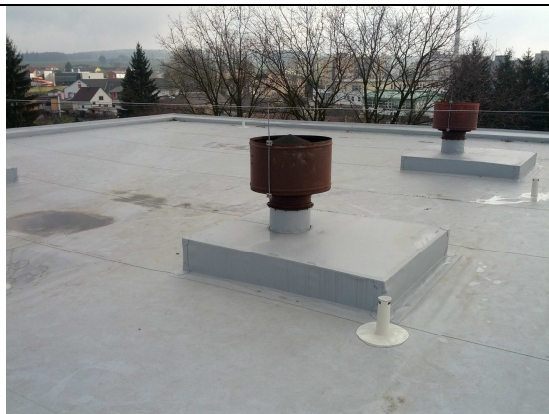
Nedokončené a nesprávně provedeny větrací komíny, neprovedené nátěry prvků VZT
