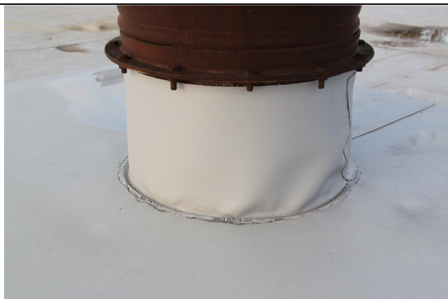
Nesprávně provedený detail napojení svislé a vodorovné PVC krytiny
