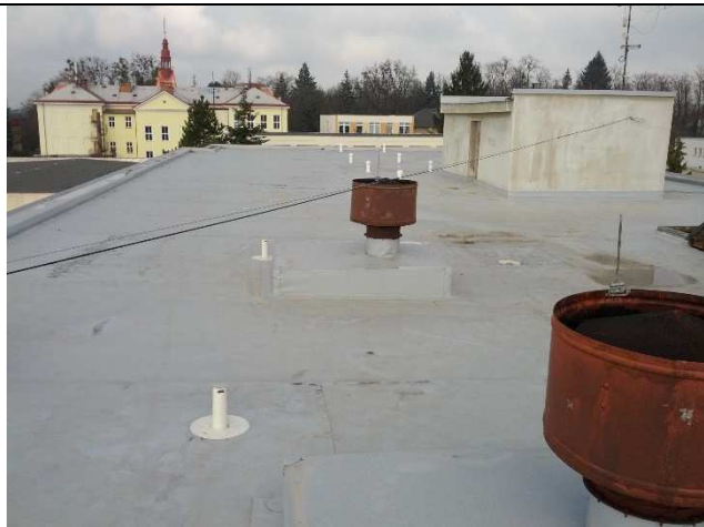
Nedokončené komínky odvětrání, chybějící úpravy povrchů VZT výdechů
