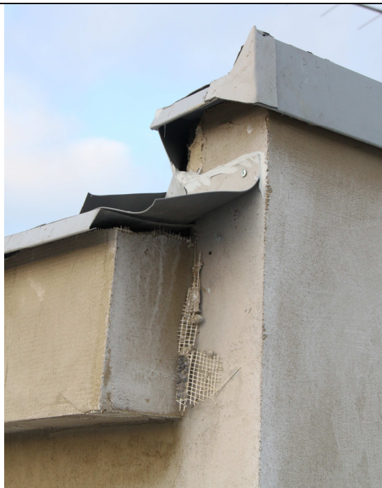
Nedokončená základní výztužná vrstva na střešní nástavbě, nesprávně (provizorně) provedené oplechování
