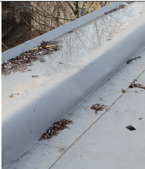
Chybějící spádová vrstva, nedostatečné navaření PVC krytiny k vnitřní a vnější rohové liště. Nevhodný způsob uchycení
