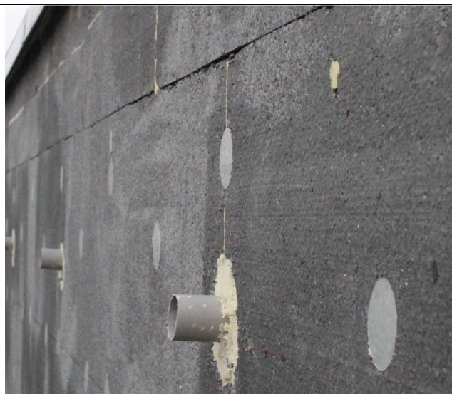
Vzniklé spáry mezi deskami vlivem slunečního záření; degradace povrchové vrstvy EPS grey, nesprávné provedení prostupů odvětrání střechy.
