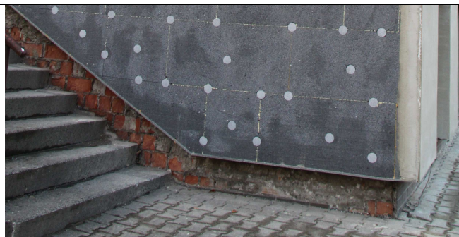
Nedokončené zateplení svislých stěn; nezapočaté zateplení soklu
