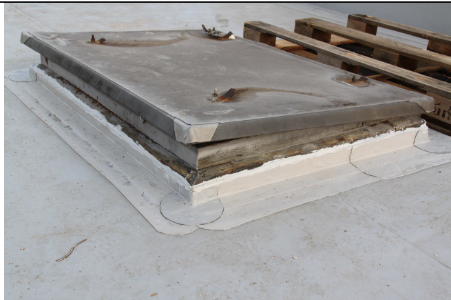
Neprovedená výměna a přizvednutí střešního výlezu
