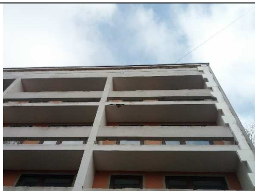
Degradace omítek vlivem chybějících klempířských prvků
