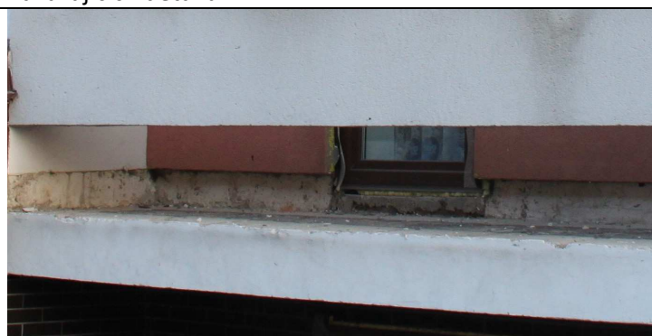
Vybourány původní kce podlah vč. klempířských prvků. Práce na nových podlahách nezapočaty
