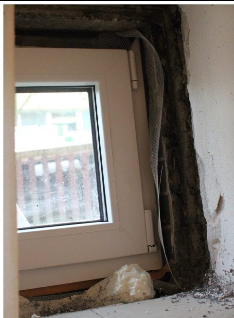
Neprovedené začištění ostění, nadpraží a parapetu po montáži části oken 1.PP
