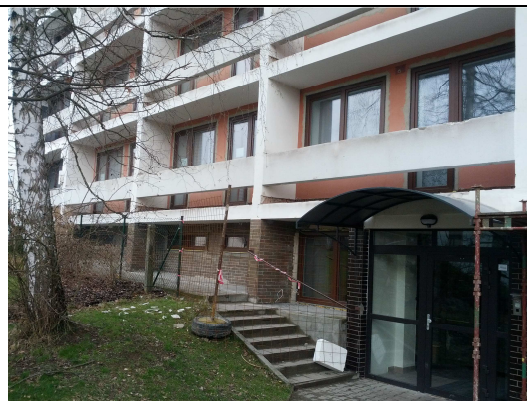
Bezpečnostní opatření proti případnému pádu kusů omítky.
