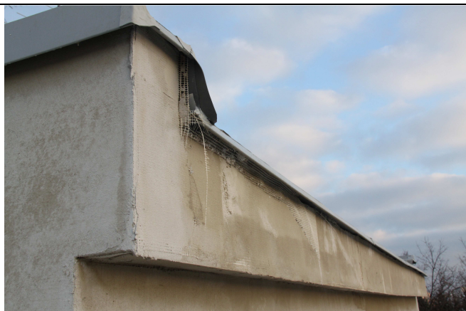
Chybně provedený nedokončený detail střešní nástavby přechodu atiky v oplechování a svislé čelo.
