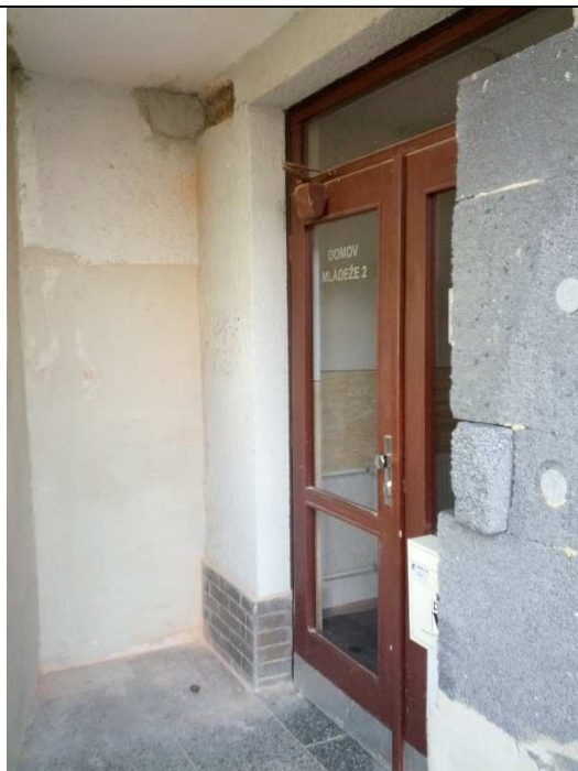
Původní dveře vstupu do objektu budou posunuty. Chybí provedení zateplení podhledu a navazujících stěn.
