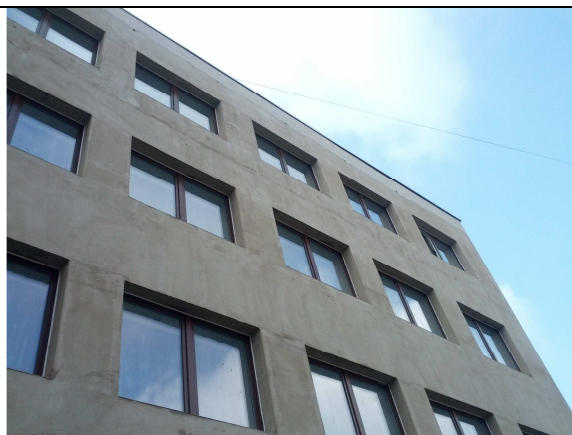
Nedostatečné přebroušení základní výztužné vrstvy. Nedostatečná tloušťka základní vrstvy horního pásu pod atikou
