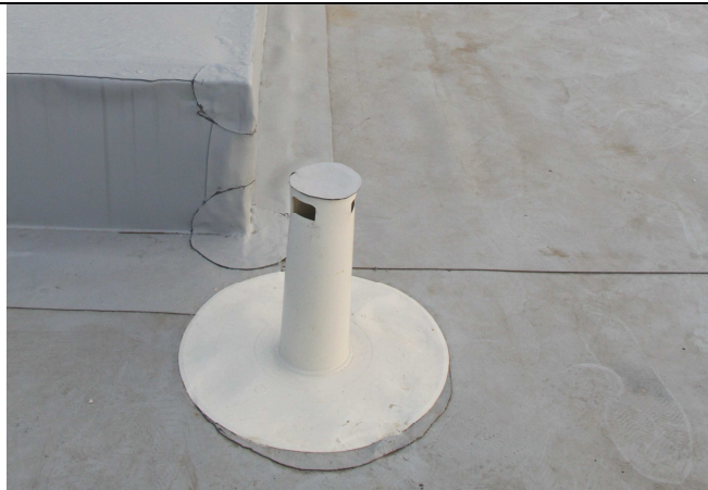
Nedokončený a nesprávně provedený větrací komínek.
