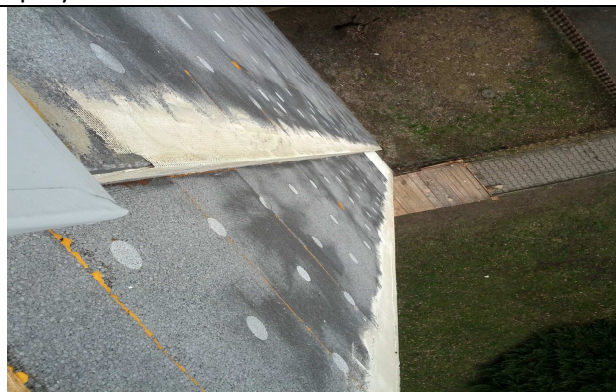
Degradace výplní pěnou
