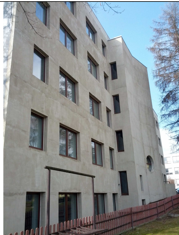
Provedeno zateplení vč. základní výztužné vrstvy; nezapočato se zateplením soklu. Chybí montáž veškerých klempířských výrobků
