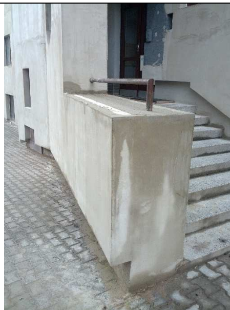
Chybí úprava původního zábradlí + chybí osazení nového zábradlí na druhé straně schodiště. Nezapočato se zateplením soklu. Část základní vrstvy degradována (nutno přebrousit a přestěrkovat)
