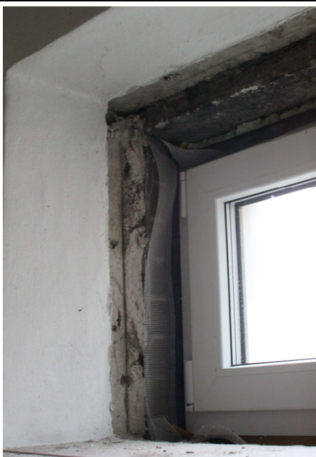
Neprovedené začištění ostění, nadpraží a parapetu po montáži části oken 1.PP
