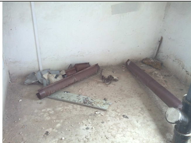
Neprovedený úklid ve střešní nástavbě. Neprovedeno zateplení podlahy.
