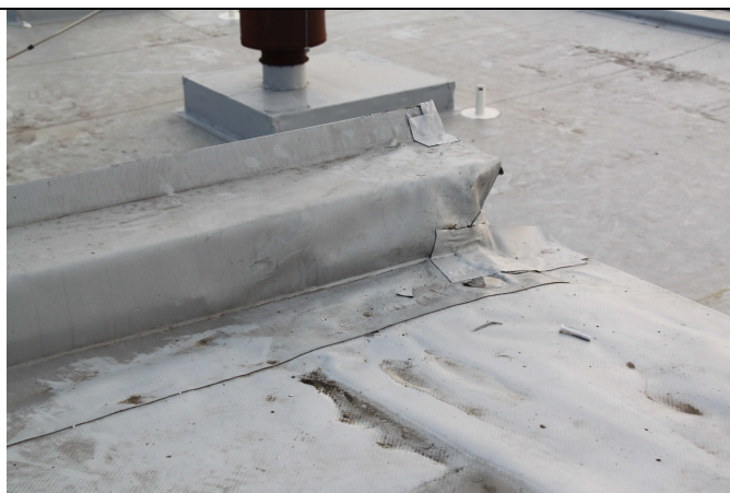
Nesprávně provedené detaily PVC krytiny střechy nástavby
