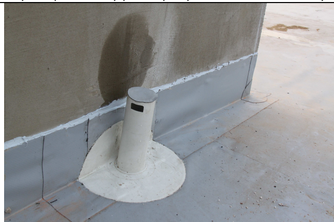
Chybně provedený a nedokončený větrací komínek. Nevhodné ukončení PVC krytiny na svislé konstrukci silikonovým tmelem.
