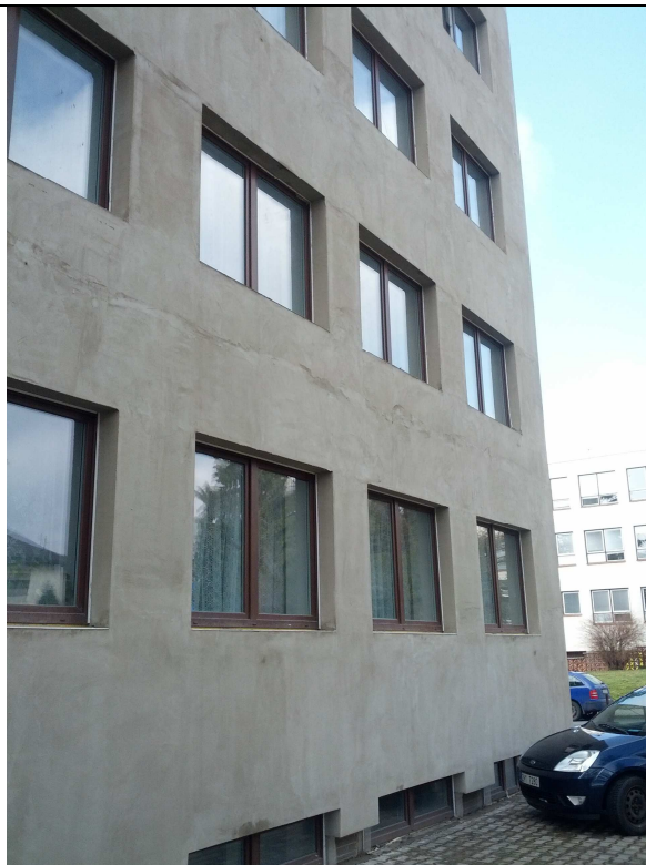
Chybějící klempířské výrobky. Chybějící zateplení soklu
