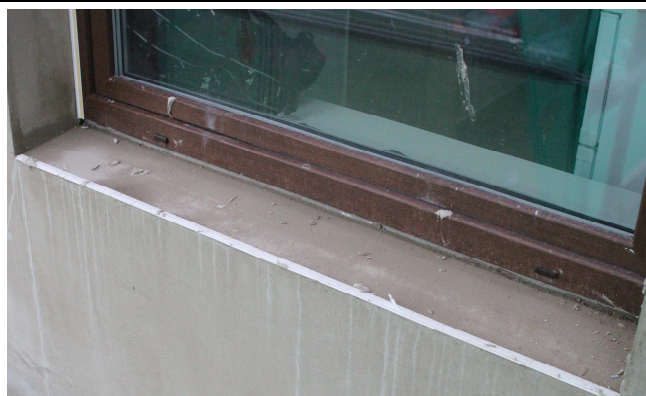
Zašpiněné rámy oken od lepidla
