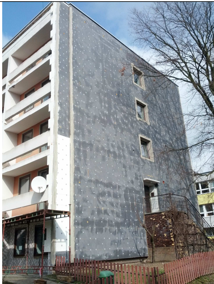
Povrch izolantu vykazuje vlivem slunečního záření degradaci. Vlivem smršťování vznikly mezi deskami spáry.
