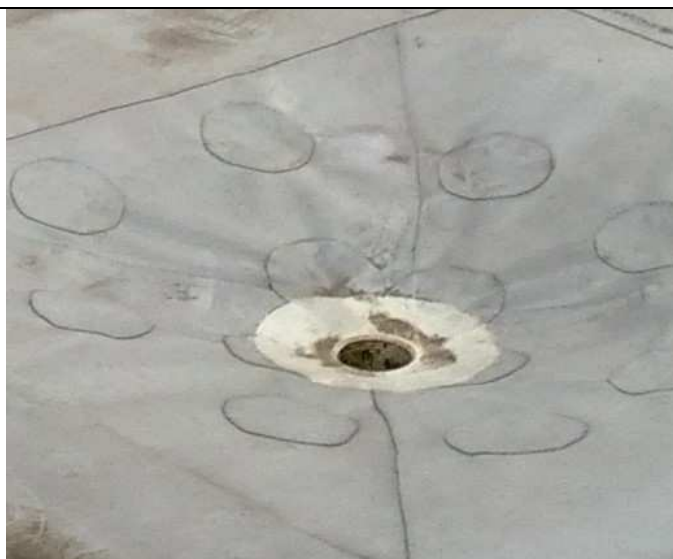
Nesystémové provedení střešních vpustí otočeným komínkem odvětrání – nutno vyměnit
