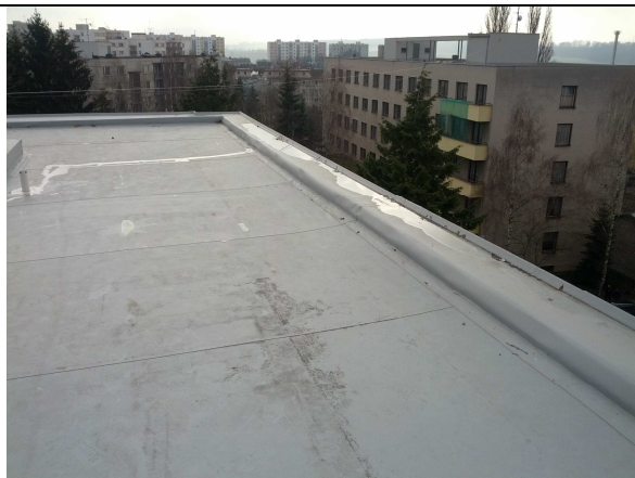
Nesprávně provedené vyspárování střešní atiky
