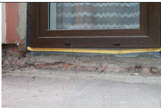
Vybourány původní kce podlah vč. klempířských prvků. Práce na nových podlahách nezapočaty
