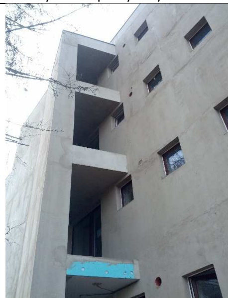
Nedostatečné přebroušení základní vrstvy (bude přebroušeno a částečně přestěrkováno)
